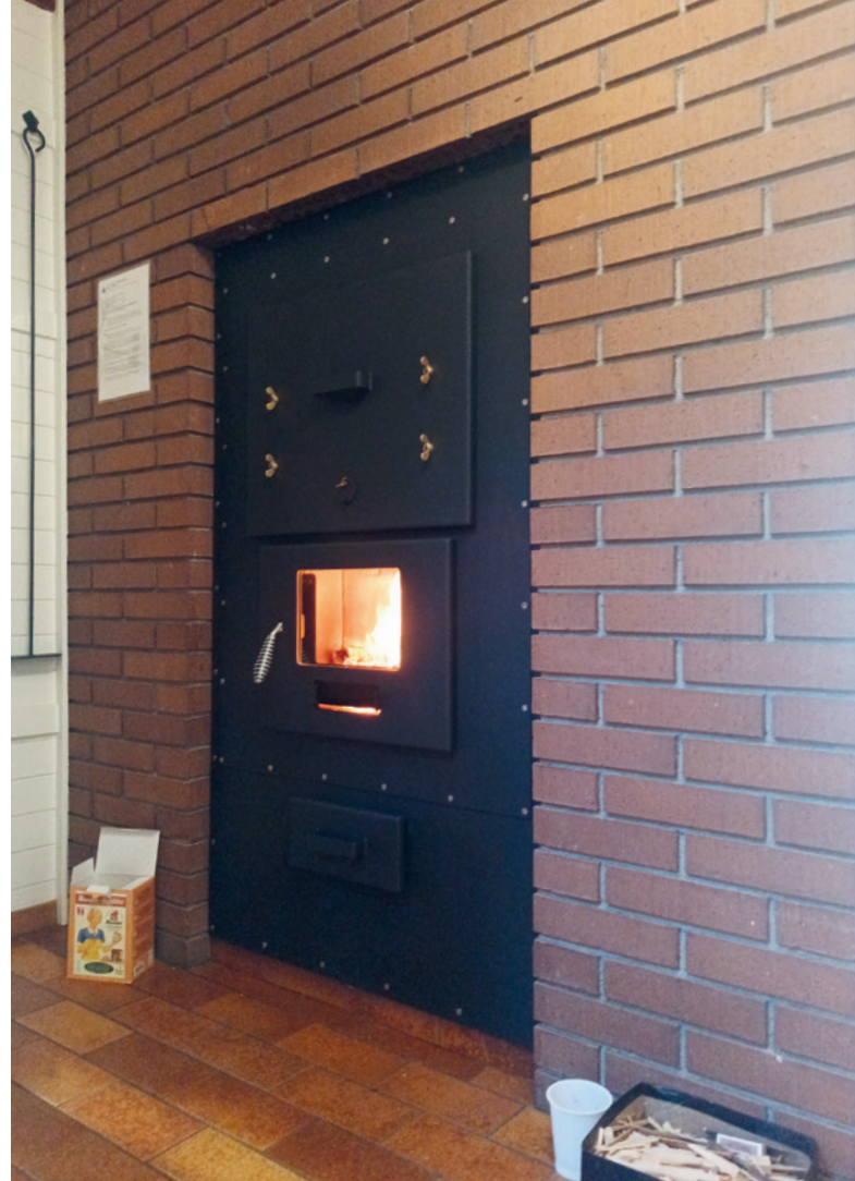
Ein wassergeführter Speicherofen erwärmt neben dem Raum auch Wasser als Wärmeträger für andere Heizflächen.
