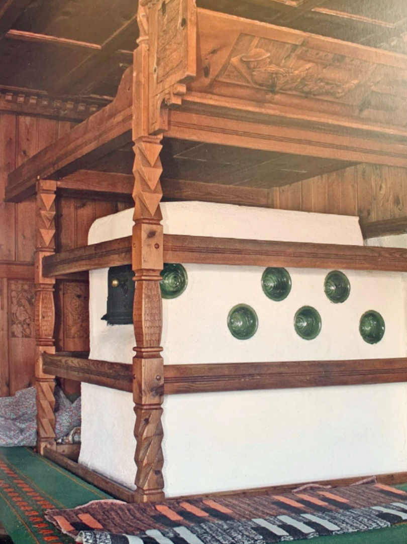
Ein restaurierter Ofen mit Napfkacheln; der Name kommt von der napf- oder schüsselförmigen Vertiefung auf der Rückseite.
